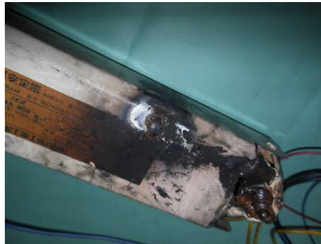
【焼損した安定器】
