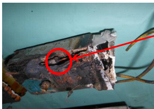
【焼損した安定器の内部】
